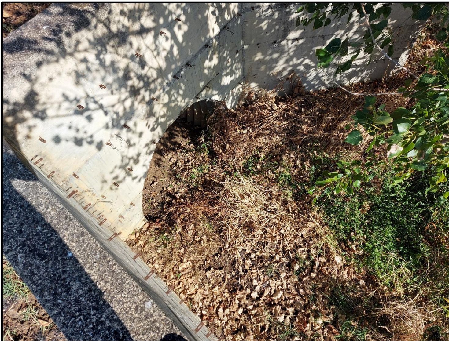
Fig. n. 3 – Stato dell'alveo del fosso Vallicellette visto dal ponte di via della Cooperazione lato S.S. 148 Pontina interno area artigianale/ind.le.
